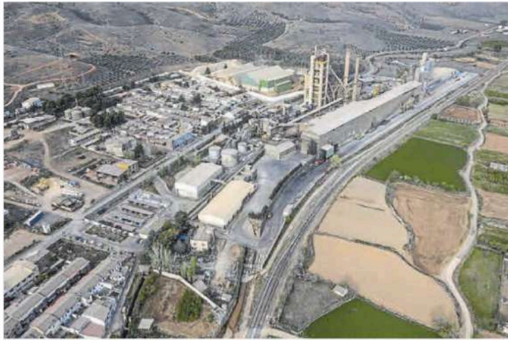
La fábrica de Morata de Jalón es la primera planta cementera en Europa en obtener la certificación 'Residuo Cero' de Aenor, que acredita la valorización de más del 95% de los residuos en su proceso industrial. | Cemex
