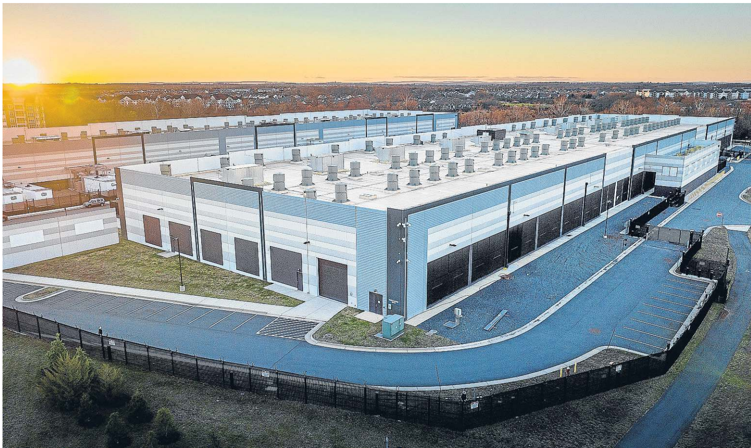
Imagen del exterior del centro de datos de Amazon Web Services. AMAZON WEB SERVICES / NOAH BERGER
